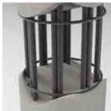
Esempio di pilastro con giunzioni meccaniche
